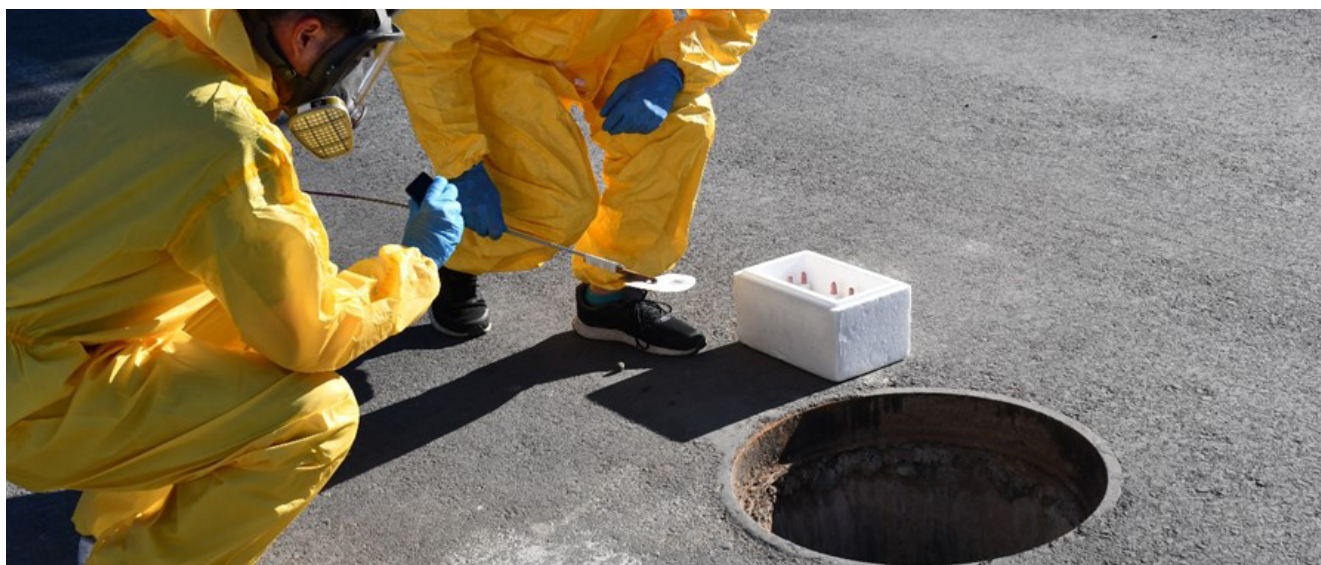
Figura 1: Personal de la AIC realizando los análisis cualitativos de la atmósfera del alcantarillado donde se intoxicaron los operarios.
